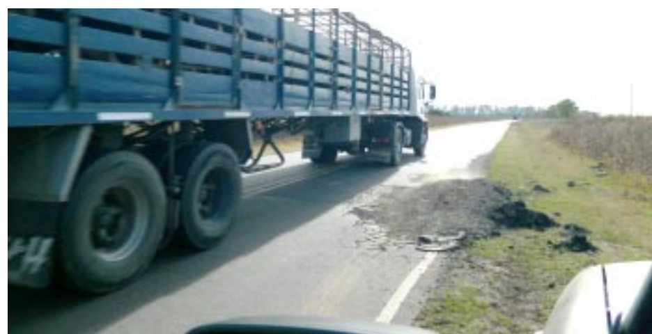
Camión elude pozo en camino a Azcuenaga
